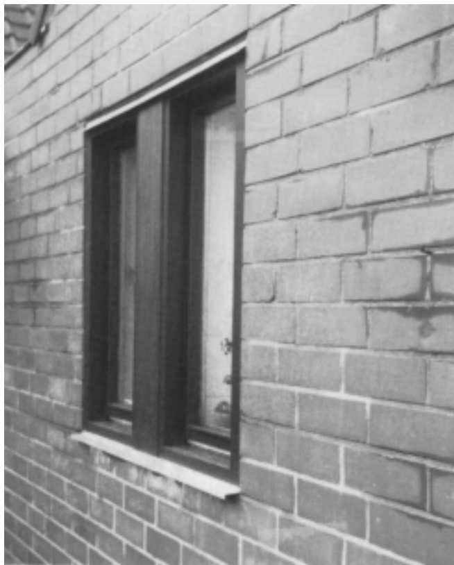
Fig. 35 Châssis posé dans le plan de la façade.
